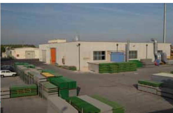
Gitterrost Zwischenlager am Werk Loreo
